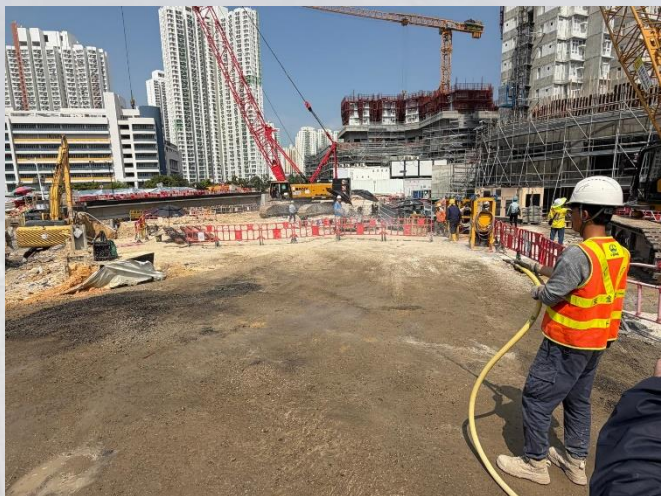
定時於工地進行灑水防止塵土飛揚
