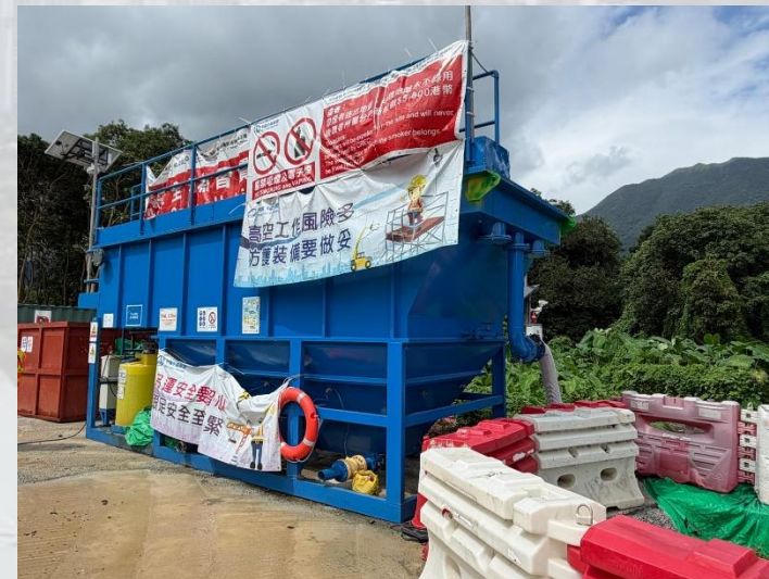
設置污水處理設施
