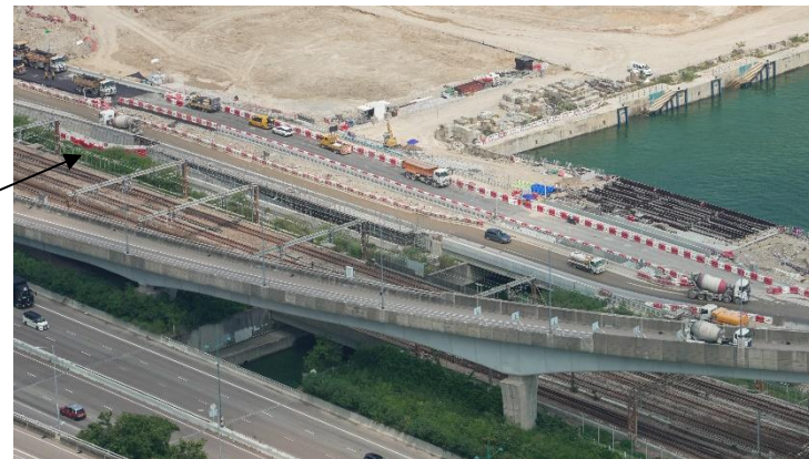
白芒隧道改建及白芒橋建造工程
