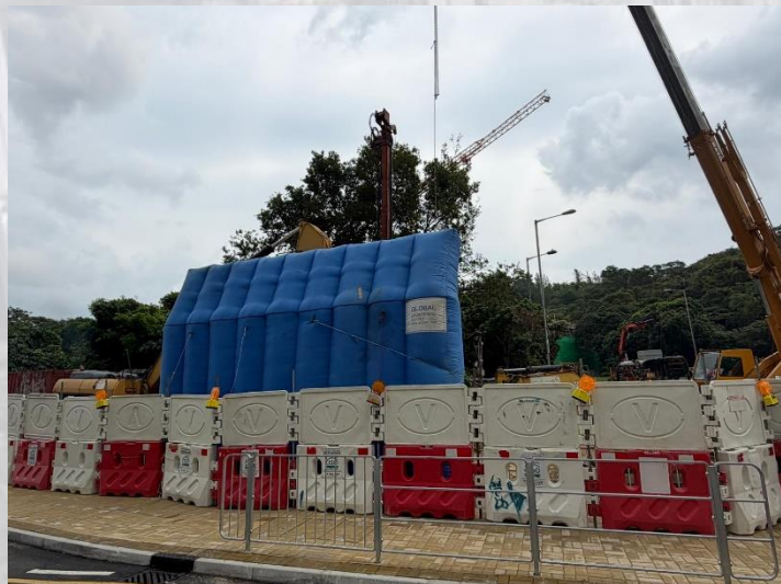
設置充氣隔音屏障
