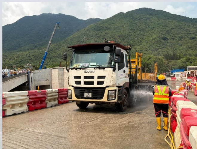
地盤出口設立洗車設施
