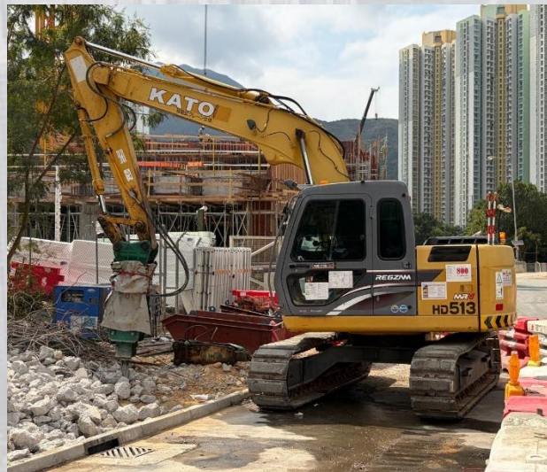
使用隔音布包裹破碎錘
