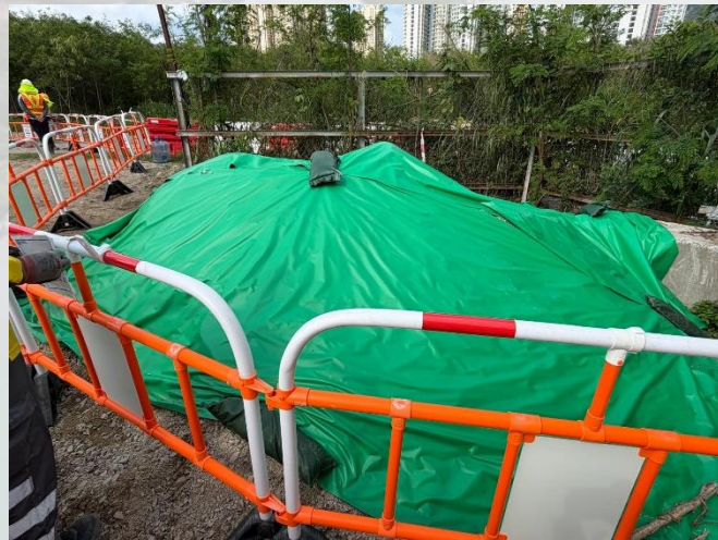
以帆布遮蓋建築物料防止塵土飛揚
