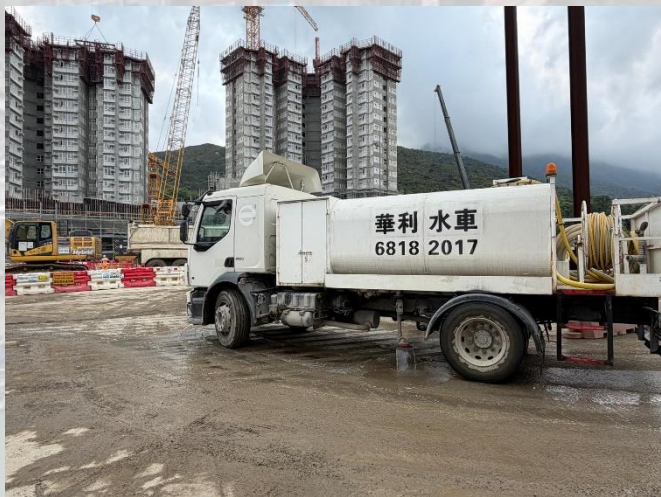
定時以水車灑水防止塵土飛揚
